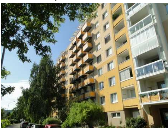
Uliční pohled na bytový dům
