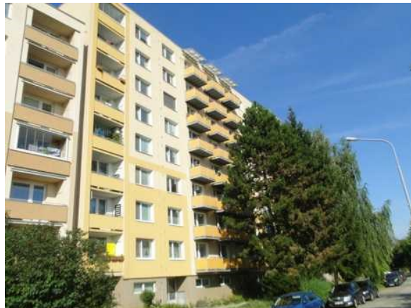
Uliční pohled na bytový dům
