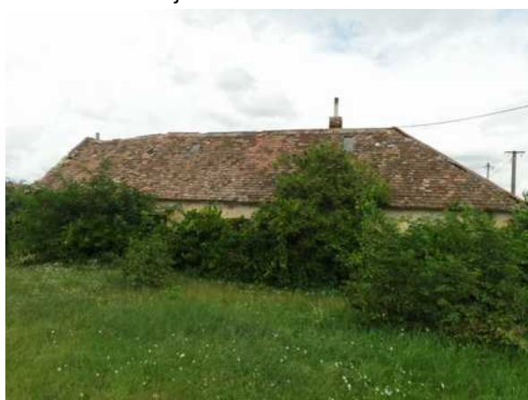
Uliční pohled na RD
