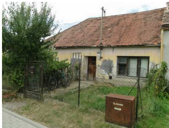
Uliční pohled na RD
