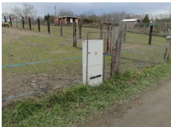
Připojení na elektroinstalaci
