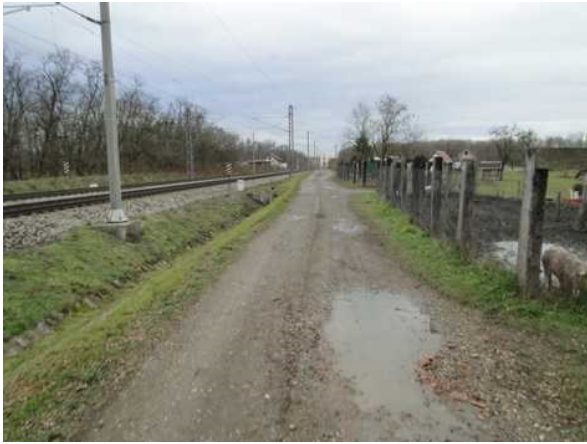
Příjezdová komunikace k zadní straně pozemku (od železnice)
