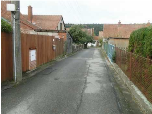
Příjezdová komunikace k domu
