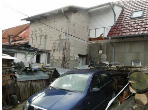
Uliční pohled na RD
