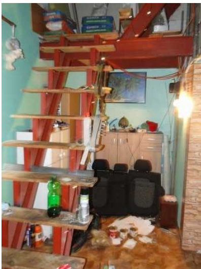
Vstupní chodba se schodištěm do podkroví
