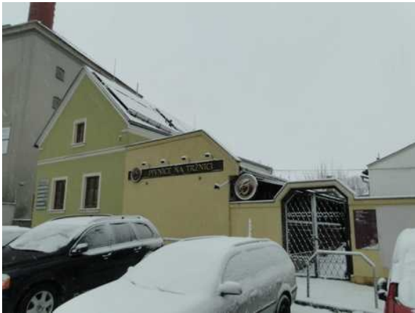
Uliční pohled na objekt
