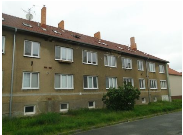
Zadní pohled na bytový dům
