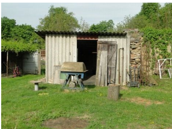
Drobné vedlejší stavby
