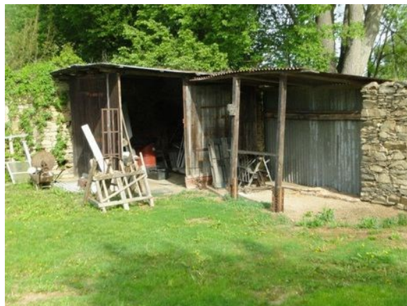
Drobné vedlejší stavby
