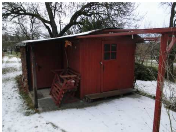
Jiná stavba bez čp/če na pozemku parc.č. 1151
