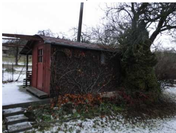
Jiná stavba bez čp/če na pozemku parc.č. 1151
