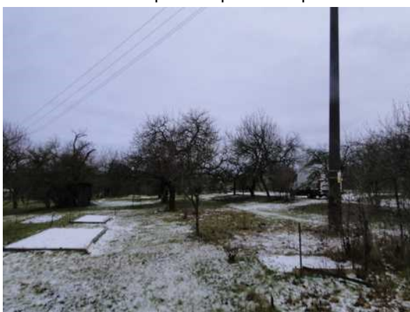
Sloup elektrického nadzemního vedení vedoucí přes pozemek
