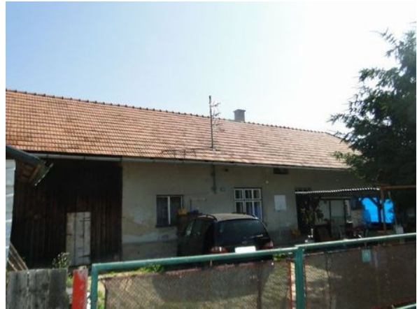
Uliční pohled na RD
