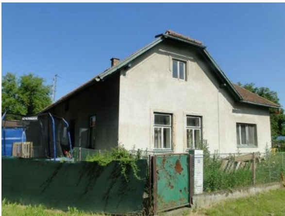
Uliční pohled na RD
