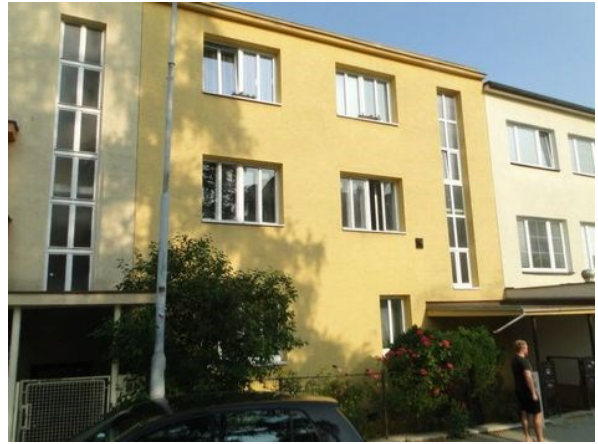
Uliční pohled na dům
