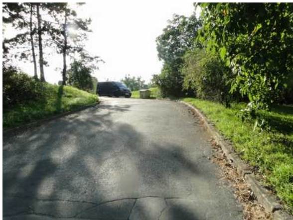
Příjezdová komunikace do lokality
