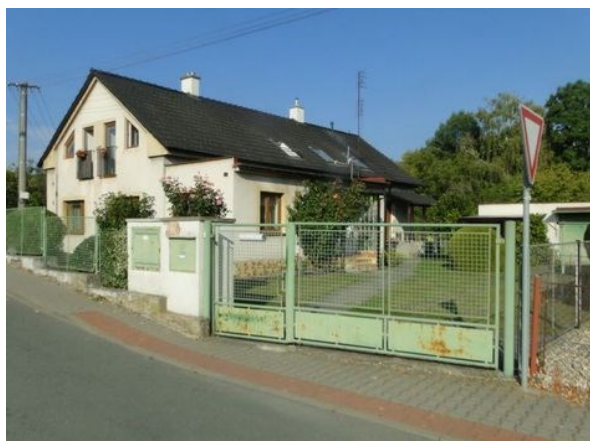
Vjezdová brána na pozemek
