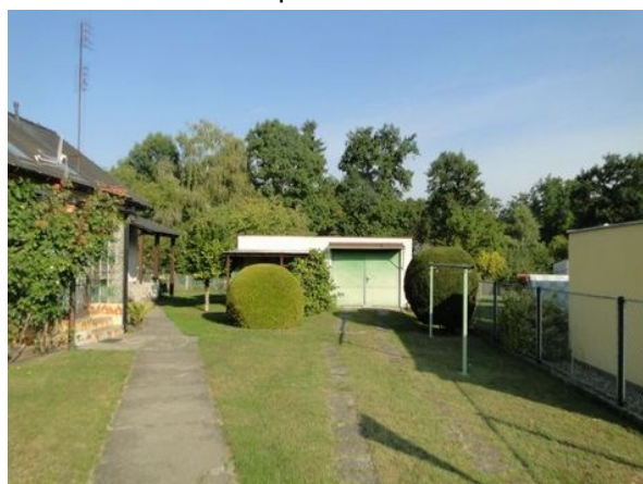
Dvorní část RD
