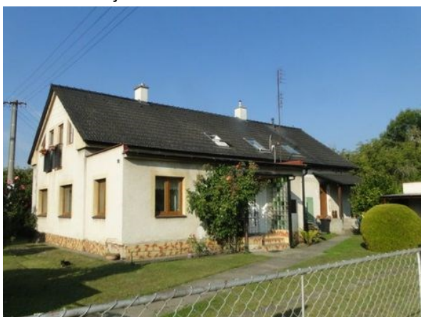
Uliční pohled na RD
