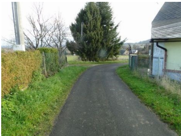
Příjezdová komunikace k RD
