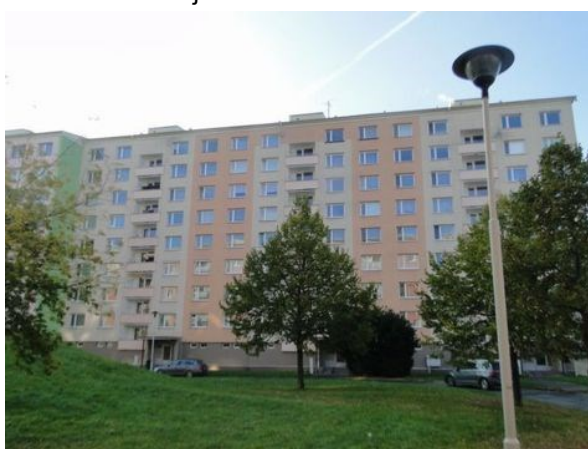
Uliční pohled na bytový dům
