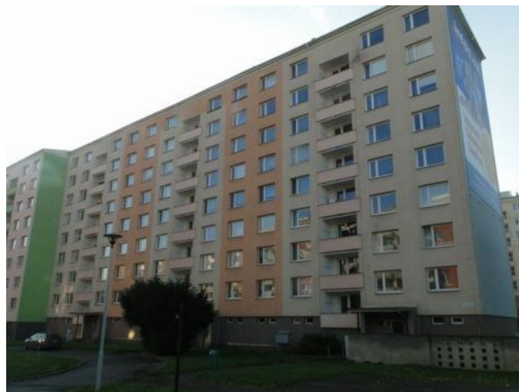
Uliční pohled na bytový dům
