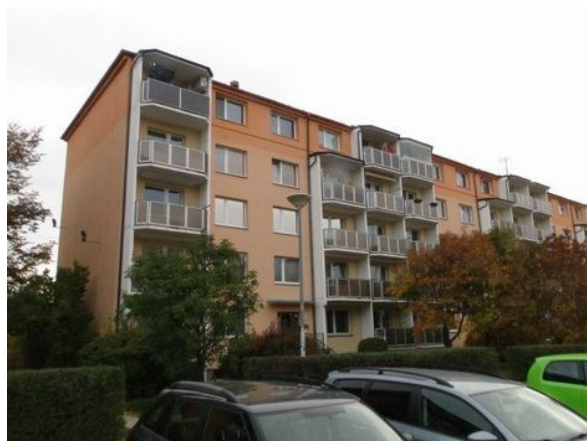
Uliční pohled na bytový dům
