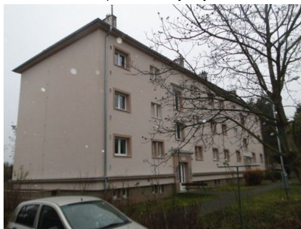
Zadní pohled na bytový dům
