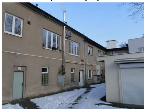
Dvorní pohled na bytový dům
