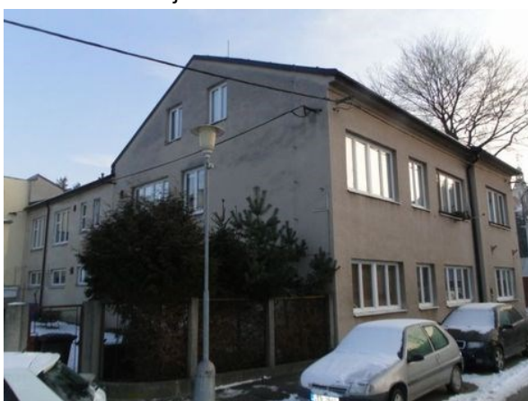
Uliční pohled na bytový dům
