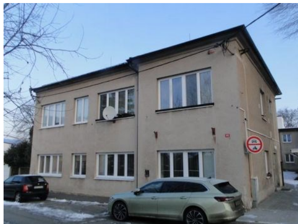
Uliční pohled na bytový dům
