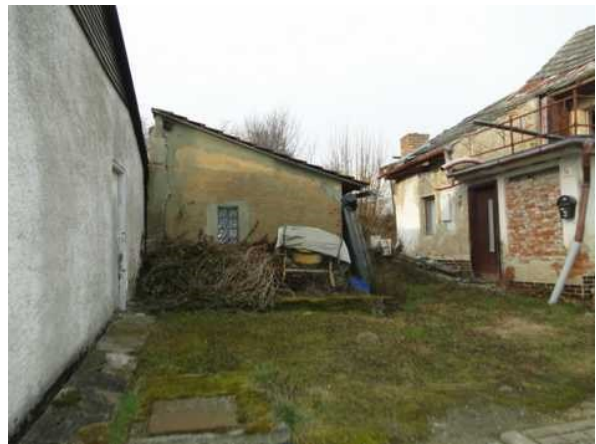
Dvorní část RD
