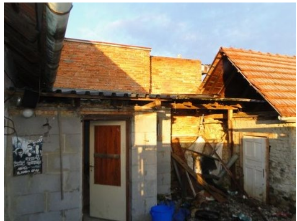
Dvorní část RD
