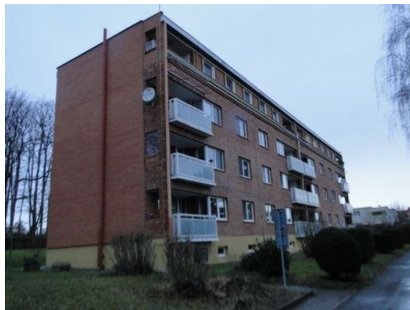
Celkový pohled na bytový dům
