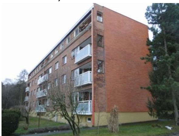
Celkový pohled na bytový dům
