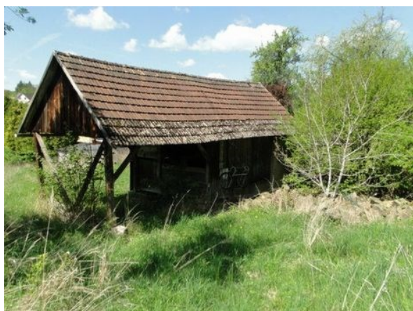
Zemědělská stavba bez čp/če
