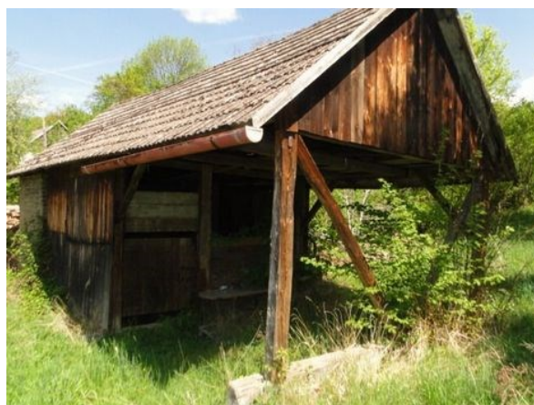
Zemědělská stavba bez čp/če
