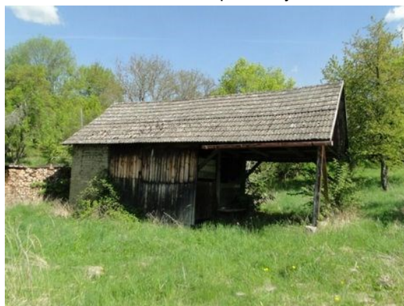
Zemědělská stavba bez čp/če
