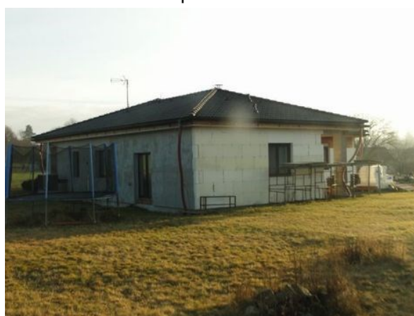
Boční pohled na RD
