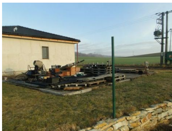
Základová deska na garáž
