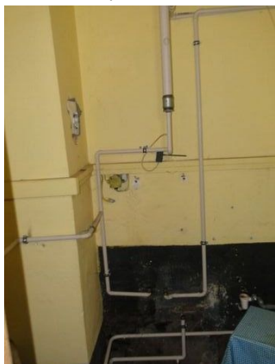
Demontovaný plynový kotel
