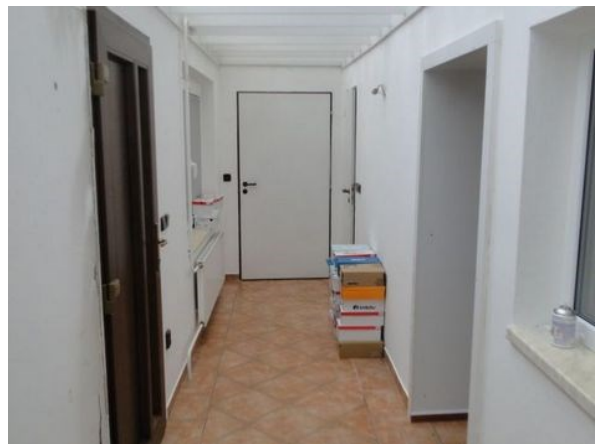
Chodba (přistavěná veranda)
