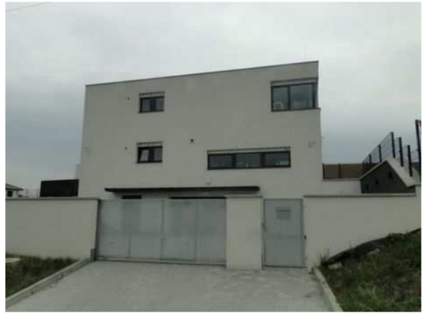
Uliční pohled na RD s vjezdem na pozemek
