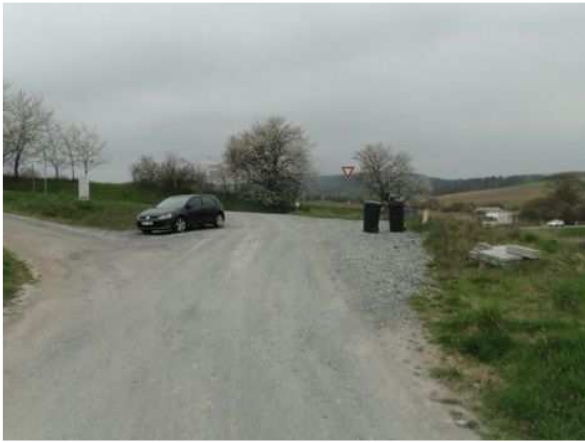
Příjezdová komunikace k RD
