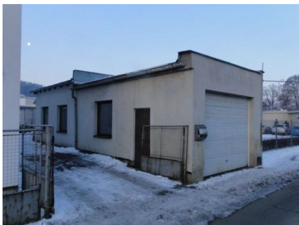
Boční pohled na garáž
