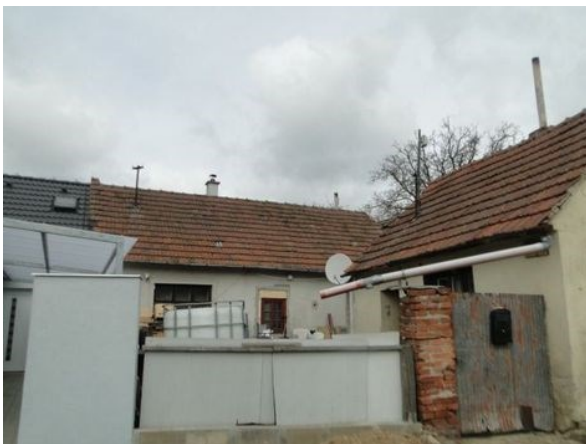
Uliční pohled na RD č.p. 216
