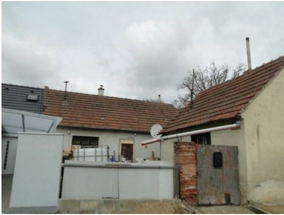
Uliční pohled na RD č.p. 216
