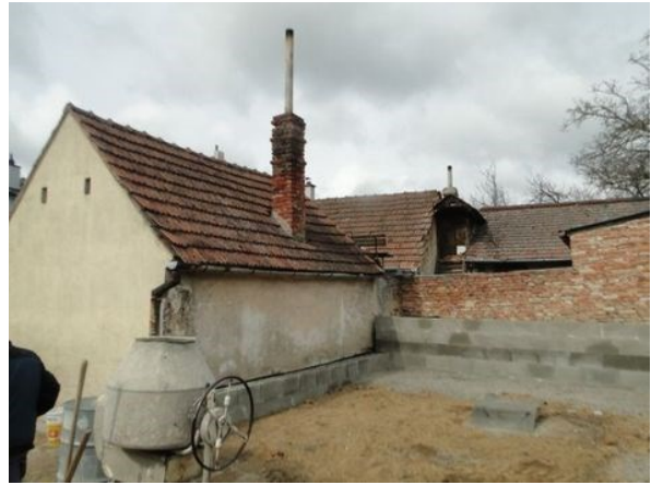
Boční pohled na RD č.p. 216
