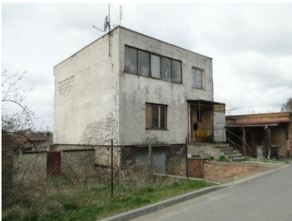
Boční pohled na RD č.p. 107
