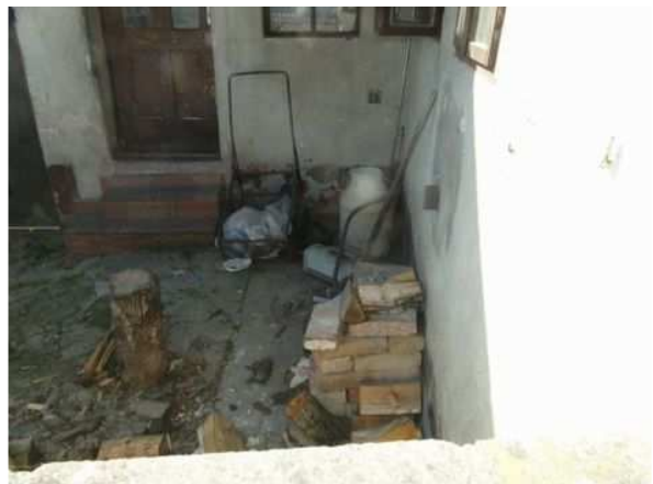
Dvorní část RD
