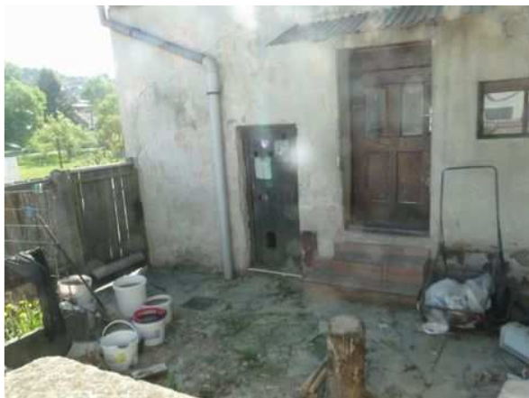
Dvorní část RD
