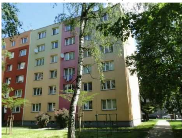
Zadní pohled na bytový dům
