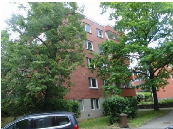
Uliční pohled na bytový dům
