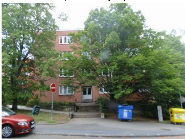
Uliční pohled na bytový dům
