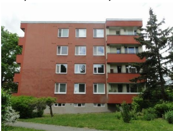
Uliční pohled na bytový dům
