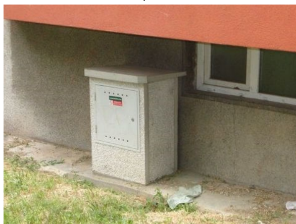
Napojení bytového domu na plyn
