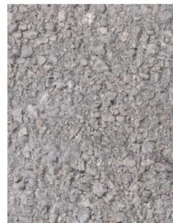
05 SOKL zapravený betonový sokl
