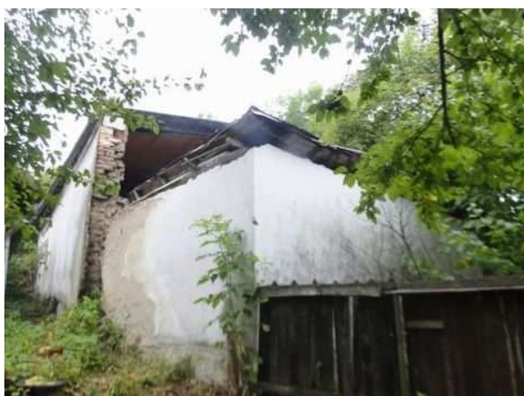
Pohled na RD
