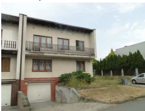
Uliční pohled na RD
