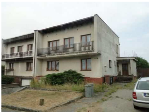
Uliční pohled na RD
