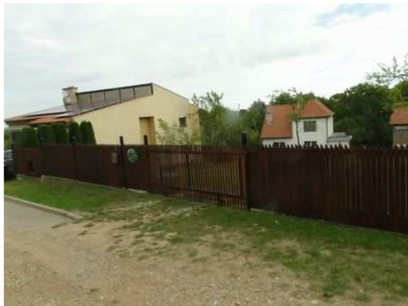
Vstup na pozemek
