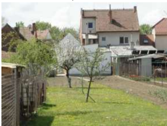
Dvorní část RD
